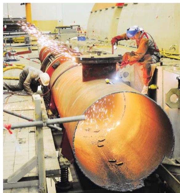
Handarbeit: Große und kleine Teile des Atomkraftwerks Obrigheim warten auf ihre Beseitigung
