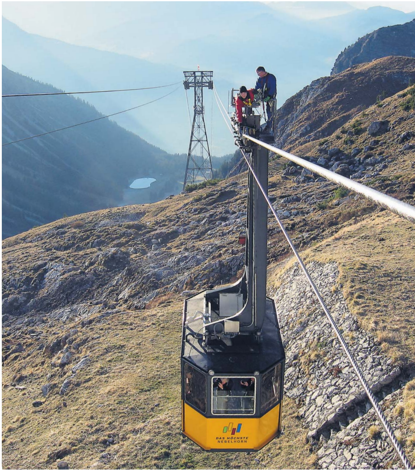
Drahtseilakt im Dienste der Sicherheit: Prüfung des Tragseils einer Bergbahn
